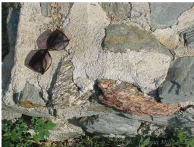
Део зида који окружује Вршачку кулу, изграђен од шкриљаца. У првом плану су два комада гнајса. Слева надесно: свежији комад сиво-бело тракастог изгледа и црвенкасти примерак, подлегао утицају временских прилика. (Фото: Татјана Милић Бабић)
