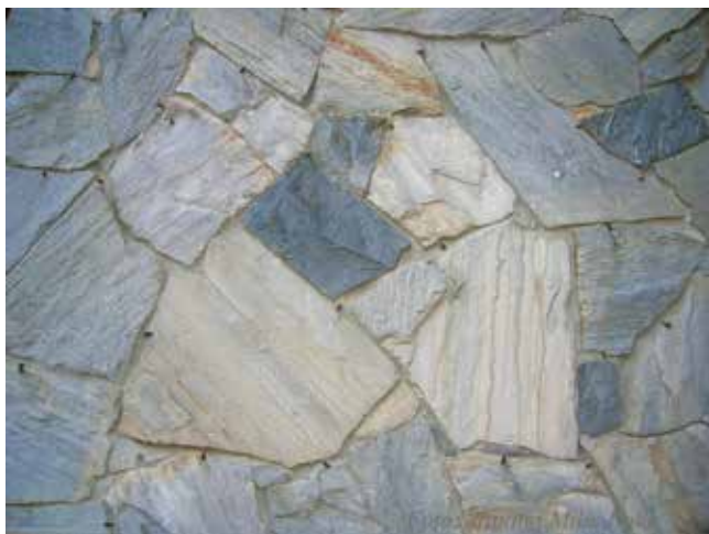
Део фасаде једне од вршачких зграда, обложен шкриљцем, највероватније пореклом са Вршачких планина.
